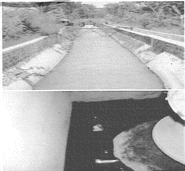
Gambar 5. PLTMH dengan memanfaatkan saluran irigasi
