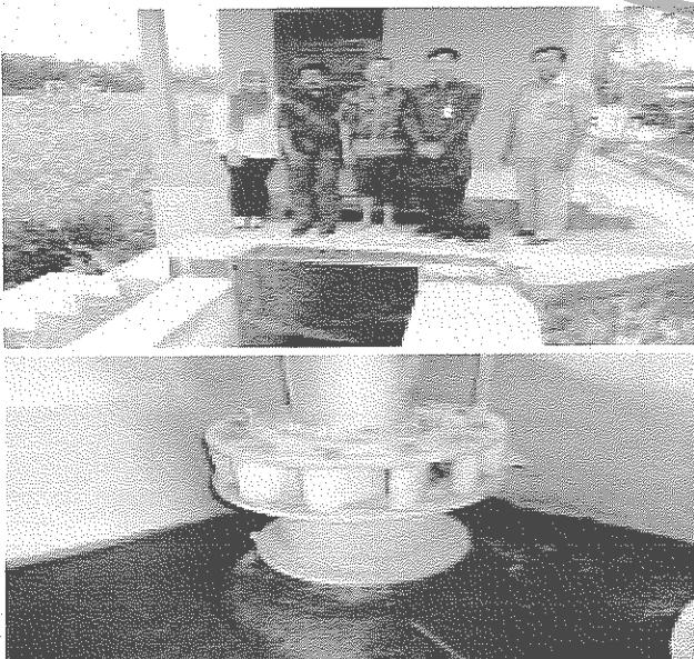
Gambar 5. PLTMH dengan memanfaatkan saluran irigasi
