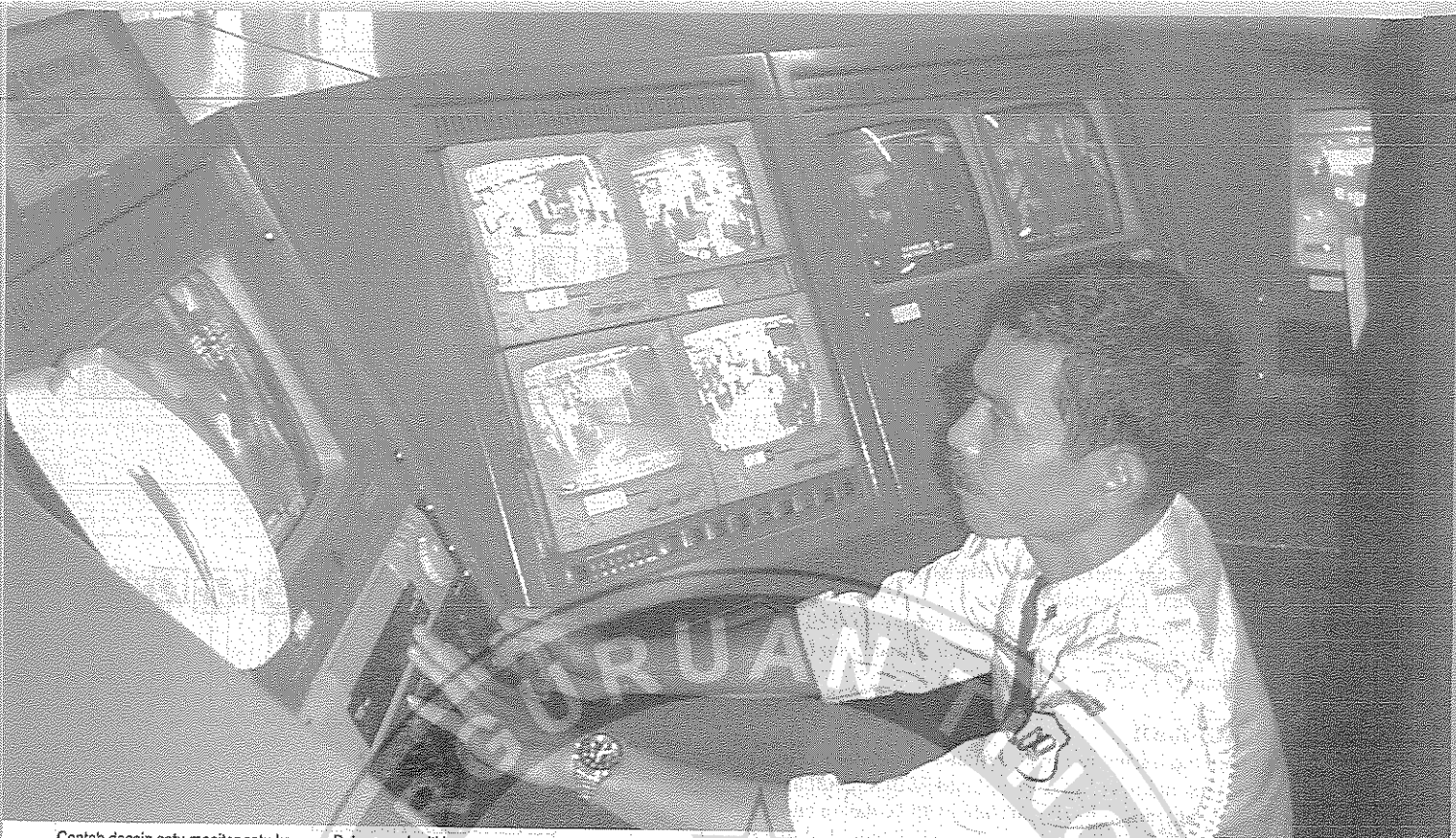
Contoh desain satu monitor satu kamera. Petugas sekuriti harus mengawasi seluruh aktivitas di layar monitor
